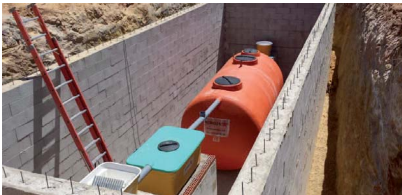
INSTALACIÓN DEPURADORA PERFIL HIDRÁULICO
