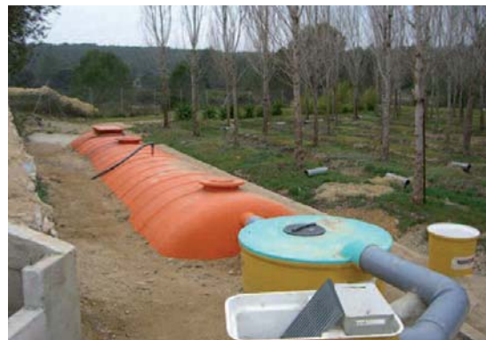
INSTALACIÓN DEPURADORA PERFIL HIDRÁULICO
