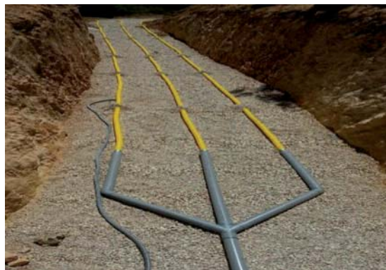
TUBOS DE DRENAJE SOBRE GRAVA EN ZANJAS
